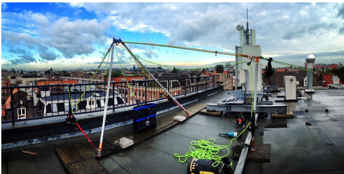
Voorbeeld opstelling multipoot langs een dakrand
