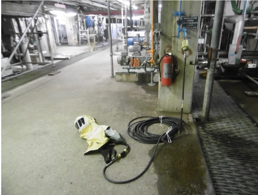
Foto 3: opbouw leefluchtsysteem.
