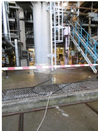
(Door het wegtrekken van de leefluchtslang door de 2 de persoon vanachter de werkplekafzetting ligt er geen spaghetti meer onderaan de koilladder)
