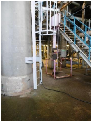
(Bij dalen door een koilladder ontstaat een spaghetti van leefluchtslang onderaan de koilladder, hierdoor ontstaat er kans op struikelgevaar)
