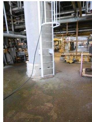
(Door het wegtrekken van de leefluchtslang door de 2 de persoon vanachter de werkplekafzetting ligt er geen spaghetti meer onderaan de koilladder)
