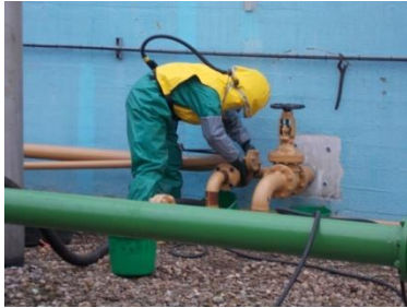
Foto 1: Ikzelf tijdens werkzaamheden waarbij het gebruik van adembescherming noodzakelijk is.
