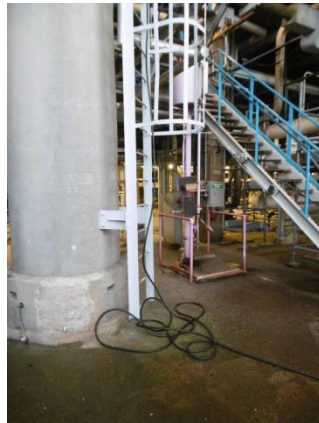
(Bij dalen door een koilladder ontstaat een spaghetti van leefluchtslang onderaan de koilladder, hierdoor ontstaat er kans op struikelgevaar)
